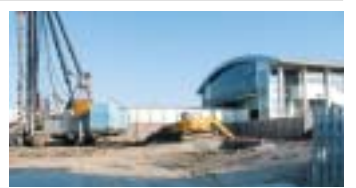
問屋町駅隣で工事中のサンクレイドル高崎
