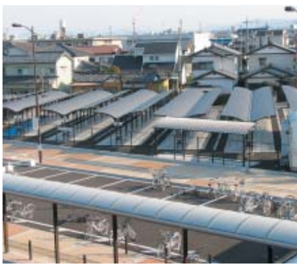
問屋町駅貝沢口に完成した駐輪場 603台収容できる
