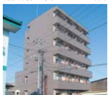
第2問屋ステーションビル
